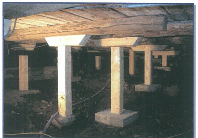
Consolidation de la structure du plancher - septembre 2011
