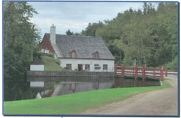
Le Moulin Les Éboulements avant la restauration
