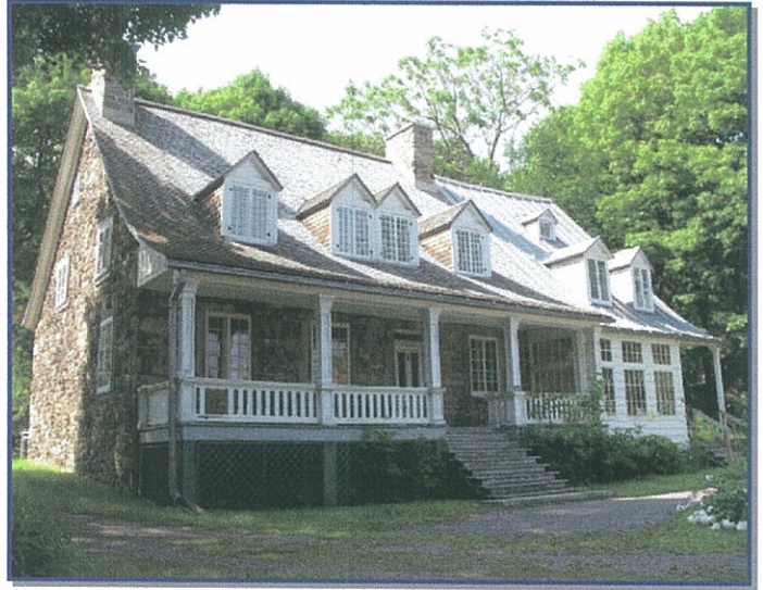
La Maison Hurtubise, juin 2011 - avant les travaux
